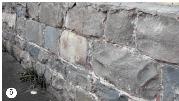
Рис. 4. Административное здание (а) на Круглой площади (пл. Ленина, д. 2) и его цоколь – старинная кладка из каменноборского кварцитопесчаника (б)
