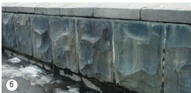
Рис. 7. Железнодорожный вокзал (пл. Гагарина) (а): стенка на остановке у здания вокзала выполнена крупными блоками каменноборского кварцитопесчаника (б)
