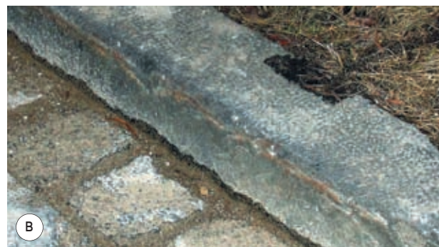
Рис. 5. Брусчатка из каменноборского кварцитопесчаника у мемориального комплекса: «Могилы Неизвестного солдата с Вечным огнем славы» на пл. Ленина (а, б) и поребрики из бортового камня (в)
