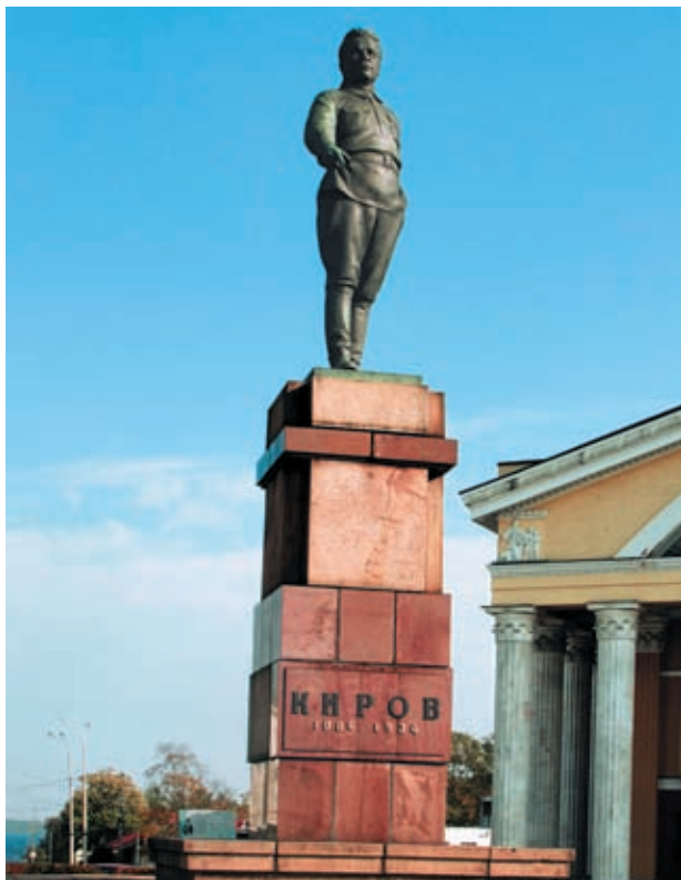
Рис. 5. Памятник С. М. Кирову (пл. Кирова в г. Петрозаводске). Пьедестал, постамент и подиум выполнены из шокшинского малинового кварцита, скульптура – бронзовая
