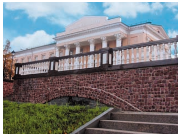
Рис. 2. Смотровая площадка лестницы у Дома физкультуры (пересечение улиц Пушкинской и Титова)
