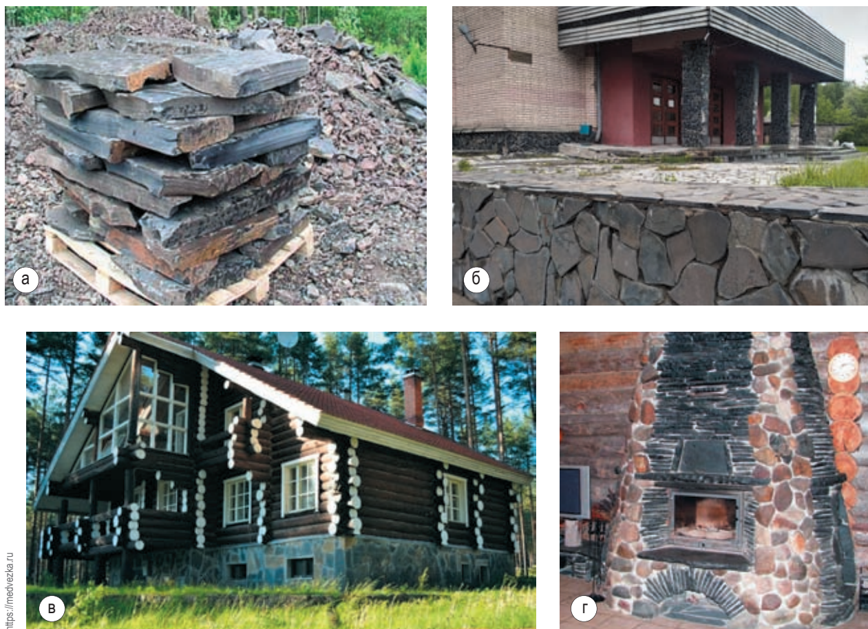
Рис. 11. Плитки – отдельные алевролита месторождения Нигозеро (а) и применение алевролитов для архитектурно-строительных работ: (б) – здание военного комиссариата Республики Карелия, (в) – загородный комплекс «Малая Медвежка», (г) – отделка камина плитками
