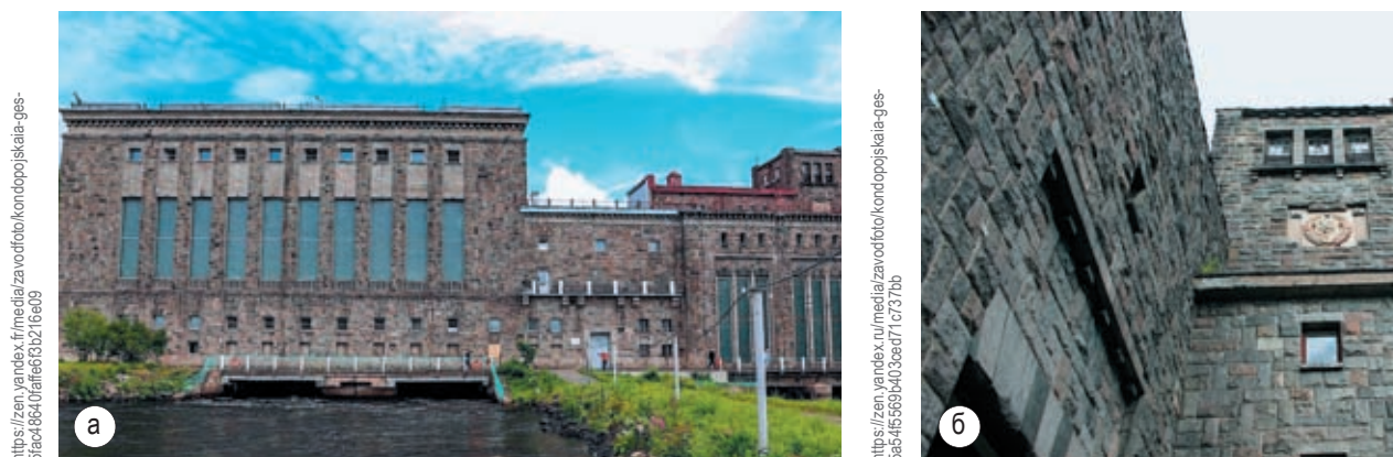
Рис. 3. Канал и здание Кондопожской ГЭС (а), отделка камнем стен здания (б)
