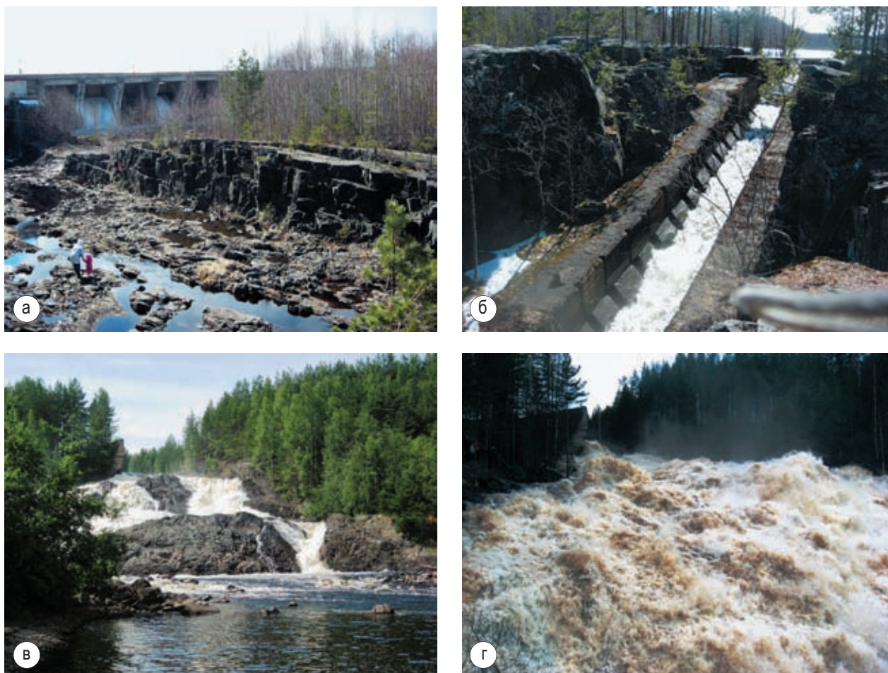
Рис. 2. Река Суна: а – каньон, русло р. Суны у плотины на въезде в пос. Гирвас, б – желоб для спуска бревен у Поор-Порога, в – пороги, г – момент сброса излишка воды у Пальеозерской (Гирвасской) ГЭС
